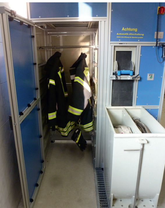
SPZ-K-RT-C Droogunit voor het drogen van interventiekleding, botten, handschoenen of brandweerslangen, plaatsbesparend in het achterste bereik van de installatie geïntegreerd
